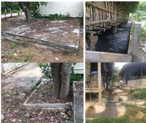
ภาพที่ 3 รางระบายน้ำเสียฟาร์มปศุสัตว์
