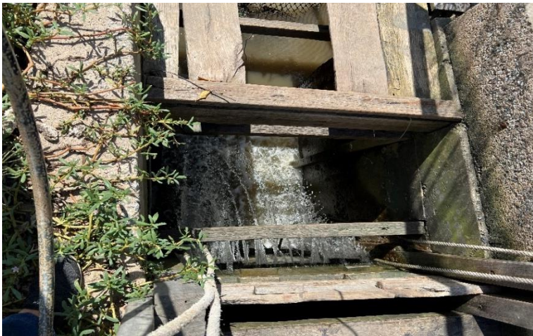
ภาพที่ 5 ประตูน้ำถ่ายเทน้ำเข้าออกบ่อ
