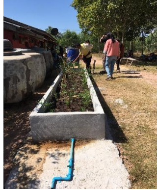
รูปที่ 5.23 ระบบบำบัดน้ำเสียจากการฟอกย้อมผ้าไหมด้วยรางพืชของกลุ่มทอผ้าบ้านอีดแตก ตำบลปราสาท จังหวัดสุรินทร์
