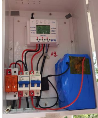
รูปที่ 2.18 การเชื่อมต่อ อุปกรณ์กับเครื่องควบคุมฯ แบบที่ 2
