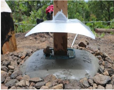
หล่อฐานเสาสัญญาณ
