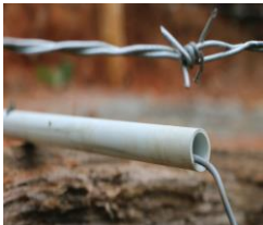
รูปที่ 5.4 การเตรียมท่อร้อยสายดินและแท่งหลักดินทองแดง
