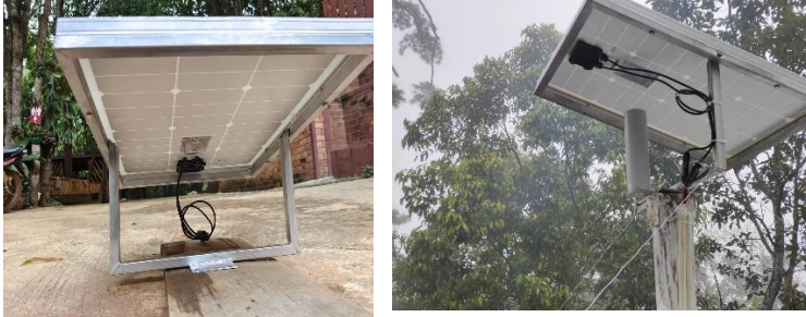
รูปที่ 5.7 การทำขายึดแผงเซลล์แสงอาทิตย์
