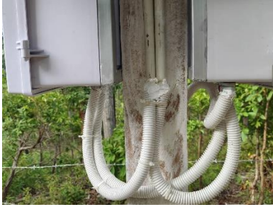
รูปที่ 5.11 การเชื่อมต่อสายไฟระหว่างตู้ควบคุม
