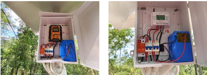
รูปที่ 5.10 การเชื่อมต่อสายไฟในตู้ควบคุมพลังงานแสงอาทิตย์
