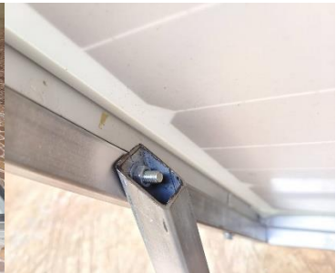
รูปที่ 5.6 การทำกรอบแผงเซลล์แสงอาทิตย์
