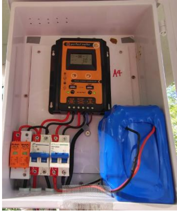
รูปที่ 2.17 การเชื่อมต่ออุปกรณ์ กับเครื่องควบคุมฯ แบบที่ 1
