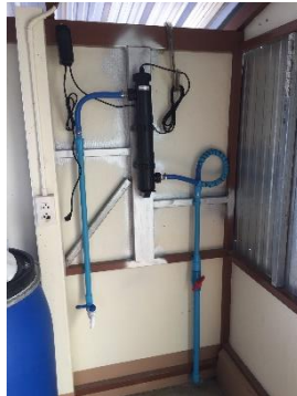
ระบบกรองน้ำด้วยรังสี UV
