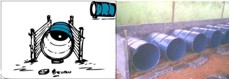
ภาพที่ 1 การวางถังขนาด 200 ลิตร
