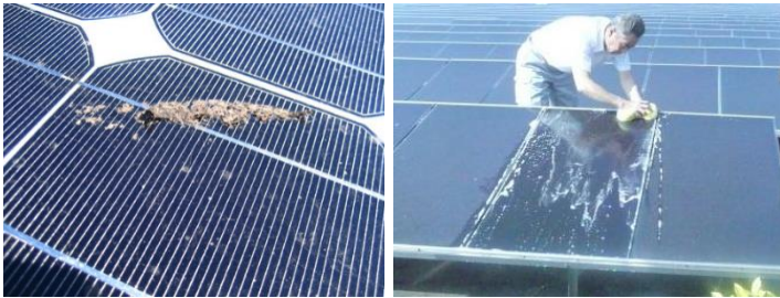
รูปที่ 4 การทำความสะอาดแผงโซลาร์เซลล์อย่างถูกวิธี
