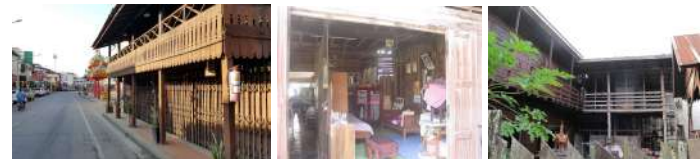
ภาพที่ 22 เรือนค้าไม้สองชั้น 4 ช่วงเสา บนหัวมุมถนนสุนทรวราช กับถนนซอยฝั่งทิศตะวันตก
