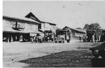
ภาพที่ 18 ห้องแถวไม้สองชั้น ที่มีการต่อเติมระเบียงด้านหน้าบนชั้นสองชั้นภายหลัง
