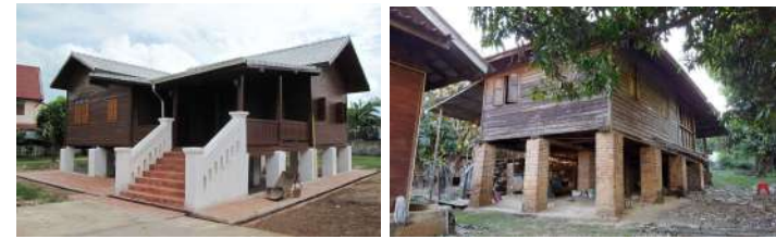
ภาพที่ 39-40 เรือนยกใต้ถุนด้วยเสาอิฐก่อในภูมิเจ้าอาวาสวัดสภารส (ซ้าย) และเรือนพักอาศัย (ขวา)
