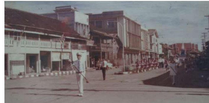
ภาพที่ 11 ภาพถ่ายก่อนเกิดเพลิงไหม้ในปี พ.ศ. 2523 สังเกตห้องแถวไม้สองชั้นยาวต่อเนื่องเป็นรูปตัว U มีการยื่นชายคาด้านหน้าอาคารระหว่างชั้นบนและชั้นล่าง และมีเสารับชายคาด้านล่าง
