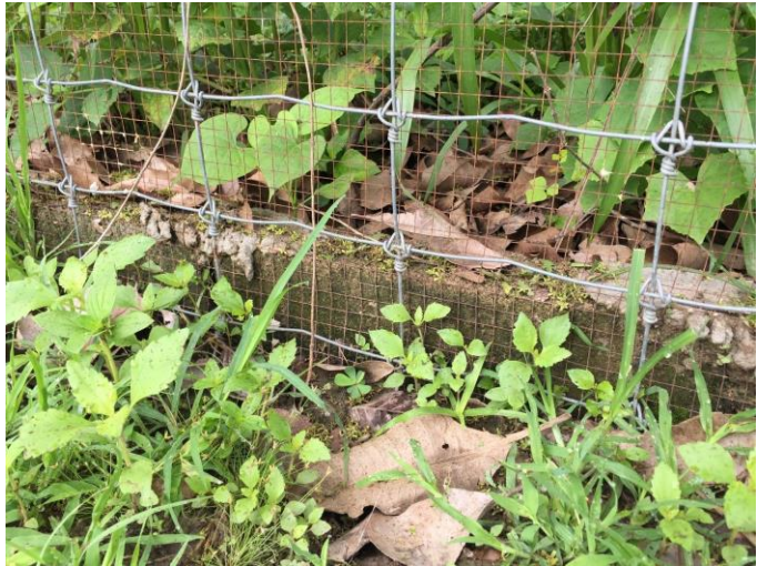
แนวอิฐบล็อกด้านนอกรั้วตาข่ายคอกกวาง ป้องกันสุนัขและสัตว์ร้าย ขุดดินมุดเข้ามาในคอกกวาง
