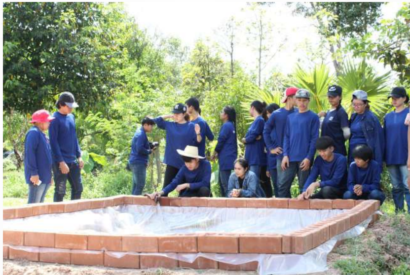
ภาพที่ 9 : การสร้างบ่อกบด้วยอิฐดินประสานปูพลาสติก
