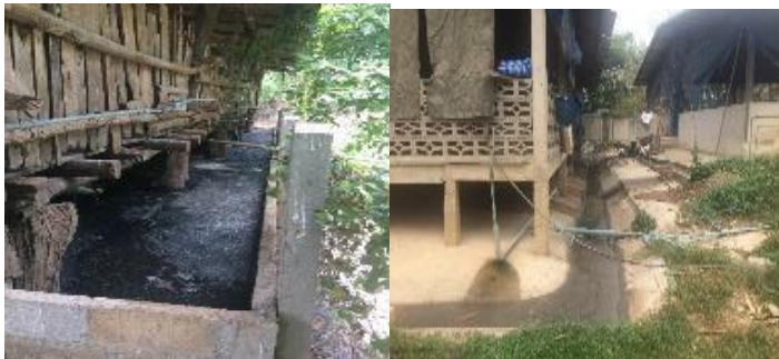
ภาพที่ 3 วางระบบน้ำเสียฟาร์มสุกร
