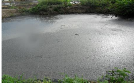
ภาพที่ 4 ระบบรวบรวมและบำบัดน้ำเสีย
