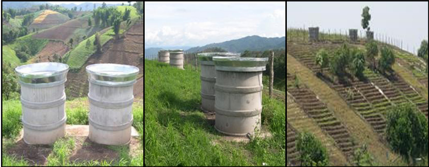
รูปแสดงการติดตั้งถังเก็บน้ำในจุดที่สูงที่สุดของแปลง
