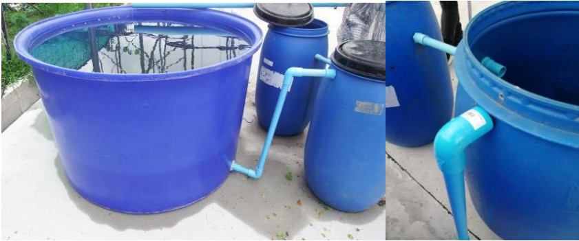
รูปที่ 5.4 การติดตั้งถังพักสารละลาย
