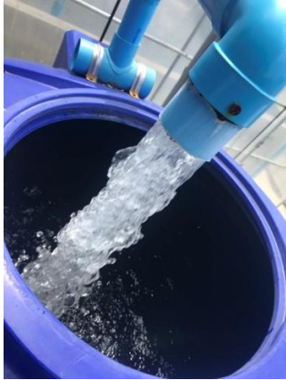
ภาพที่ 5 ถังกรองตะกอน(mechanical filtration Tank)
