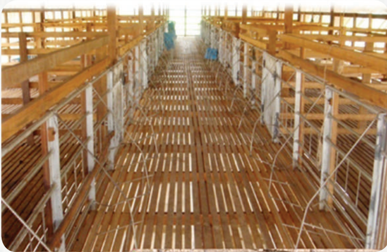
ตัวอย่าง พื้นโรงเรือนทำด้วยไม้เนื้อแข็งมีช่องว่างระหว่างไม้ เพื่อให้มูลตกลงไปด้านล่าง
