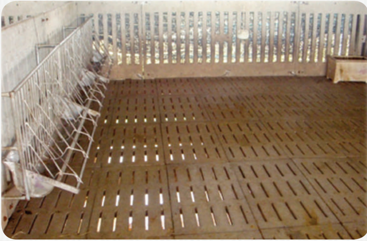
ตัวอย่าง พื้นโรงเรือนทำด้วยสแลตปูน
