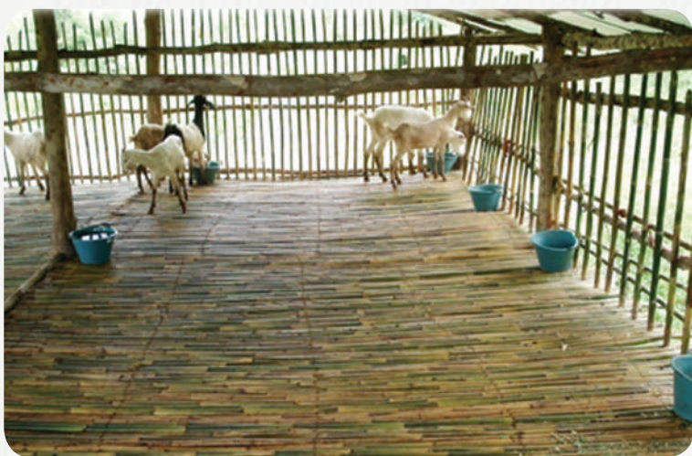
ตัวอย่าง พื้นโรงเรือนทำด้วยไม้ไผ่รวก
