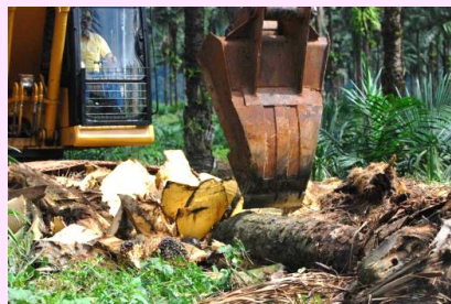
ภาพที่ 4.19 การทำลายต้นปาล์มน้ำมันเก่า โดยใช้รถแบคโฮล้มแล้วสับต้น
