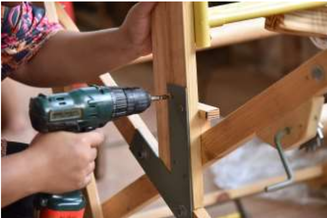
รูปที่ 2.11 ติดตั้งเหล็กตัววีเพื่อยึดเสาของกึ่งทั้ง 2 ด้าน
