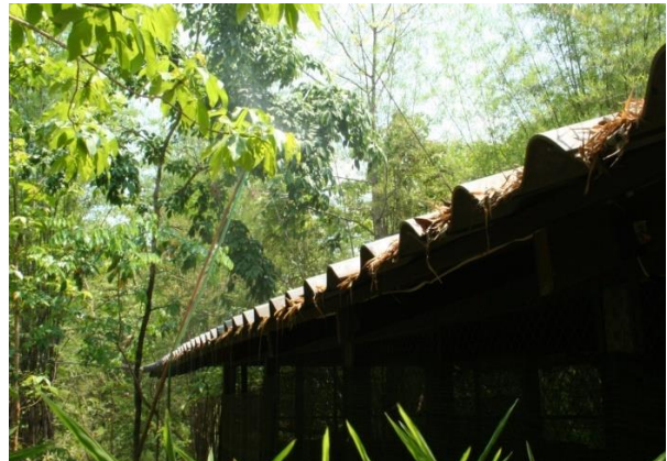
สปริงเกอร์น้ำเหนือหลังคาโรงเรือน
