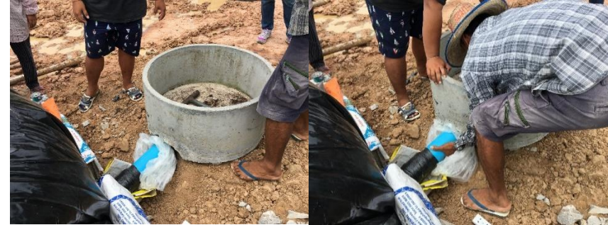
ภาพที่ ๙ จัดท่อเติมและท่อล้น
