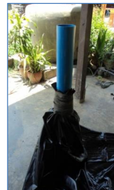
ภาพที่ ๕ ปลายท่อที่ผูกกับปากถุงเรียบร้อยแล้ว
