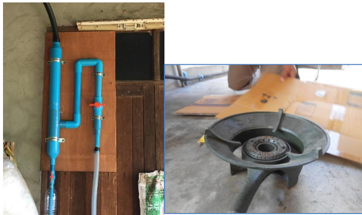
ภาพที่ ๑๑ การวางท่อแก๊สกับหัวเตา
