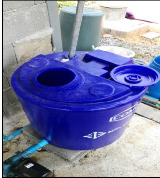
รูปที่ 29 ถังเก็บน้ำร้อนที่ผลิตได้
