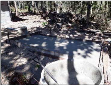
รูปที่ 16 การเตรียมพื้นที่ทำบ่อหมัก
