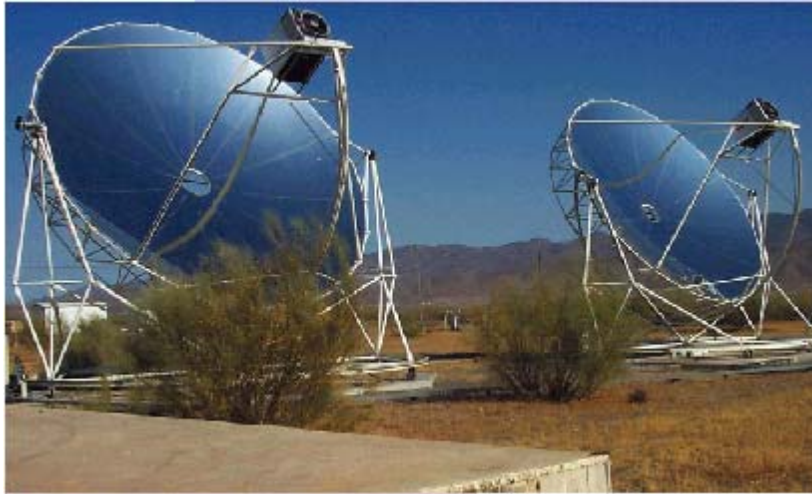
รูปที่ 7 ระบบ Dish Sterling Engine
