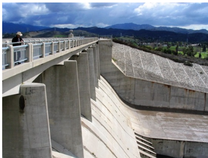
รูปที่ 9 โรงไฟฟ้าพลังงานน้ำ
