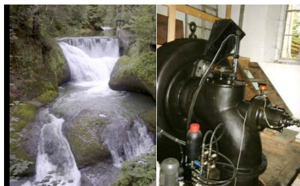
รูปที่ 14 ระบบผลิตไฟฟ้าพลังงานน้ำ Mini – hydro
