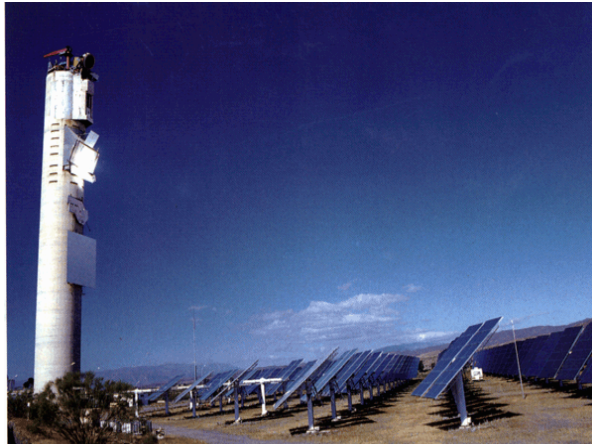
รูปที่ 5 ระบบ Power Tower
