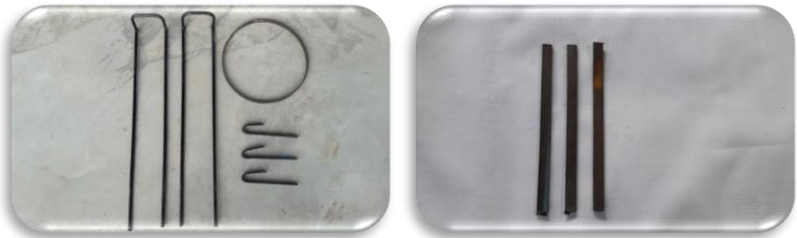
รูปที่ 21 การตัดและดัดเหล็ก
