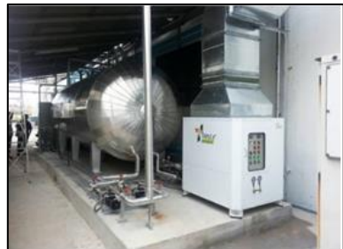
รูปที่ 7 เครื่องผลิตน้ำร้อนแบบระบบผสมผสาน
