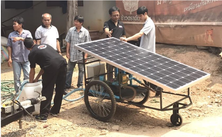
รูปที่ 16 ระบบสูบน้ำพลังงานแสงอาทิตย์ขนาดเล็ก สง.พลังงานจังหวัดพะเยา
