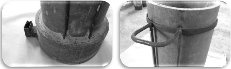
รูปที่ 24 การเทฐานด้วยปูนทราย
