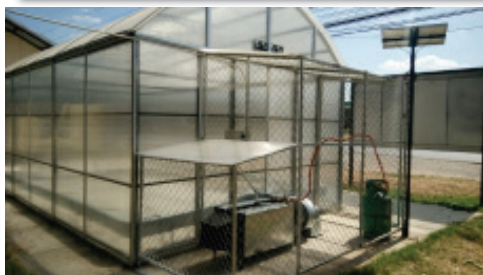
2. การสร้างและติดตั้งระบบความร้อนเสริมอินฟราเรดแก๊สเบอร์เนอร์
