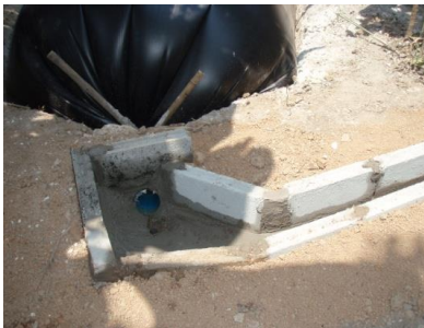
ภาพที่ 3.17 ตัวอย่างทางเข้าบ่อหมักก๊าซชีวภาพ
