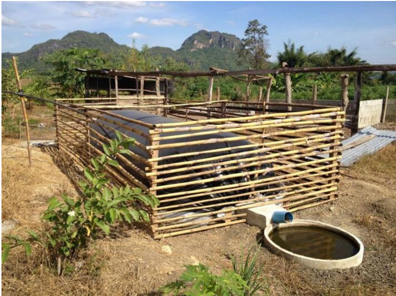
ภาพที่ 3.16 ตัวอย่างการล้อมคอกด้วยไม้ไผ่และการเทปูนที่เรียบร้อยสวยงาม
