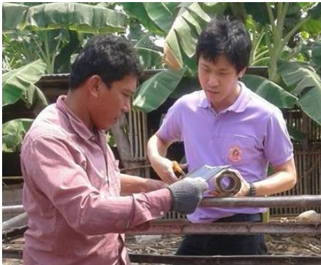
ภาพที่ 3.23 ตัวอย่างการปะรอยฉีกขาดของถุงพลาสติกพีอีด้วยซีลเก็ท
