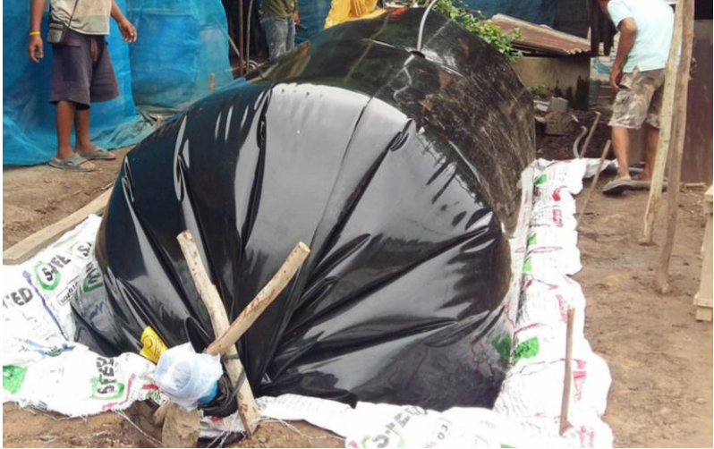
ภาพที่ 3.13 ตัวอย่างการมัดไม้เป็นรูปกากบาทเพื่อยึดท่อพีวีซีกับทางเข้าออก
