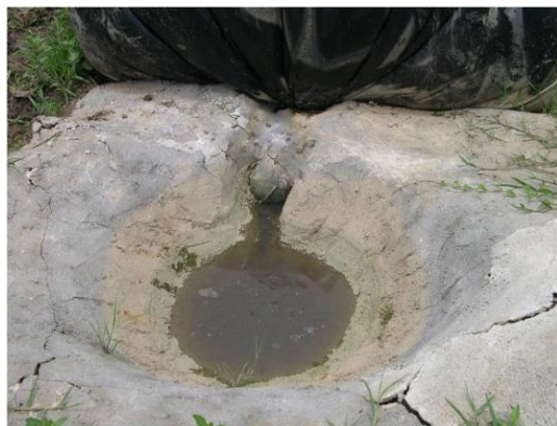
ภาพที่ 3.18 ตัวอย่างทางออกบ่อหมักก๊าซชีวภาพ
