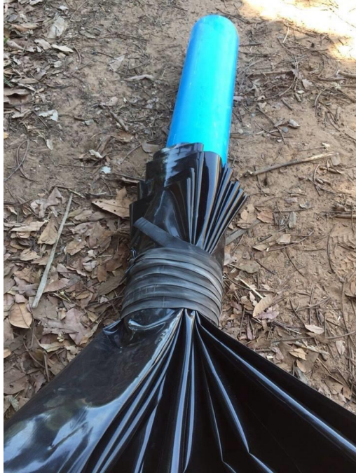
ภาพที่ 3.9 ตัวอย่างการใช้ยางในรถมิดปากถุงพลาสติกพีอีเข้ากันก่อนพรีซี
