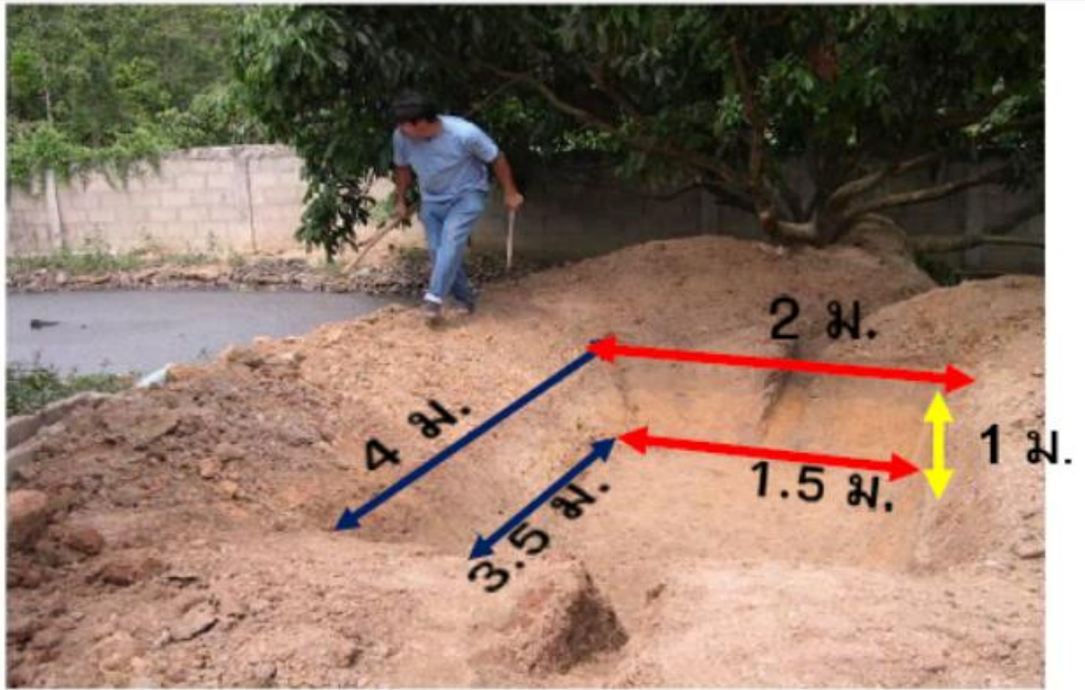
ภาพที่ 3.4 ขนาดบ่อกที่เหมาะสมกับถุงพลาสติกพีอีขนาด 7-8 ลูกบาศก์เมตร
