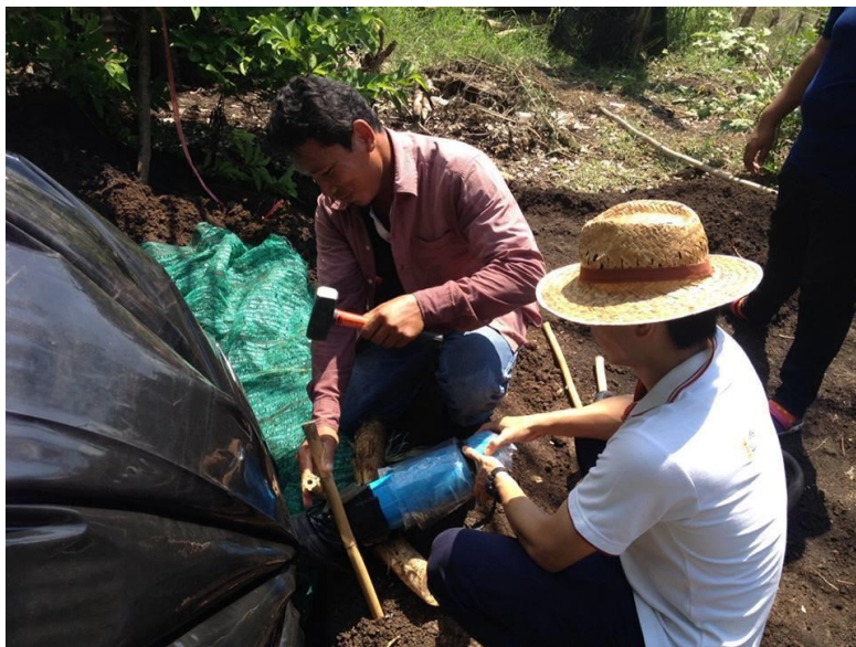
ภาพที่ 3.12 การยึดท่อพีวีซีกับทางเข้าออกด้วยไม้ชัดเป็นรูปกากบาท
