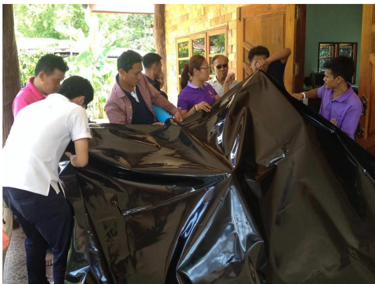
ภาพที่ 3.8 การมัดปากถุงพลาสติกพื้อีเข้ากับท่อพีวีซี
