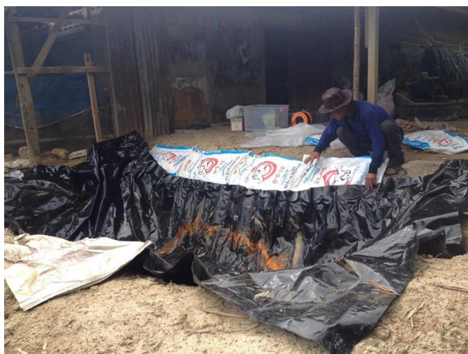
ภาพที่ 3.5 ตัวอย่างการขุดบ่อมาตรฐานโดยนำถุงพลาสติก กระสอบปุ๋ย สแลน หรือ ฟาโบลมารองบ่อกันสิ่งมีคม
