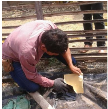
ภาพที่ 3.23 ตัวอย่างการปะรอยฉีกขาดของถุงพลาสติกพีอีด้วยซีลเก็ท
