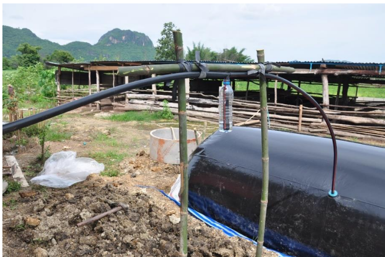
ภาพที่ 3.15 การติดตั้งก่อนนำส่งก๊าซที่มีขนาดปรับความดันต่อจากถุงพลาสติกพีอี
