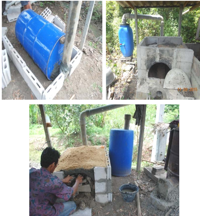
ภาพที่ 6 การต่อท่อทางออกให้จุ่มปลายท่อลงถึงที่บรรจุน้ำ เพื่อท่อดักควินและการวางท่อนเหล็กเพื่อรองรับวัสดุที่ผลิตถ่านชีวภาพ
