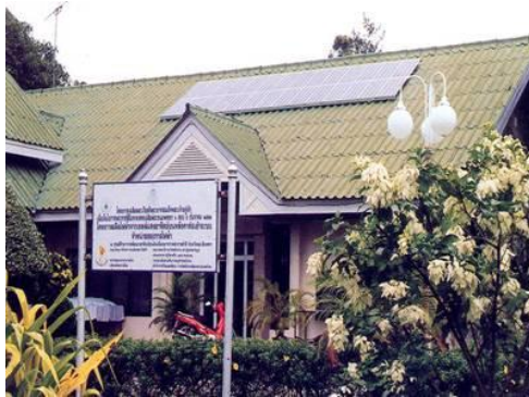
ภาพที่ 3.3 ระบบผลิตไฟฟ้าด้วยเซลล์แสงอาทิตย์เชื่อมต่อสายส่งการไฟฟ้าฝ่ายผลิตแห่งประเทศไทย
