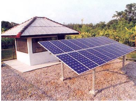
ภาพที่ 3.1 ระบบสูบน้ำด้วยไฟฟ้าจากเซลล์แสงอาทิตย์แบบกระแสตรง
