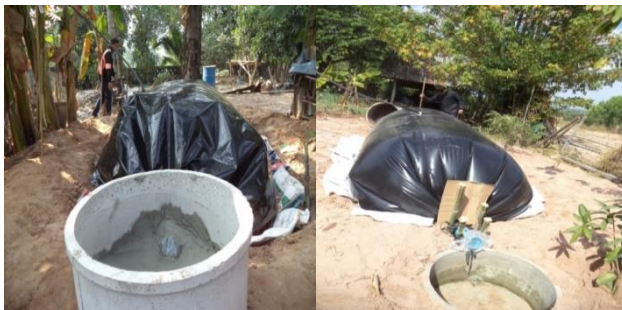
รูปที่ 15. ทำบ่อล้นและบ่อเติม
