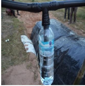
รูปที่ 6. ชุดดักจับไอน้ำและปรับแรงดันก๊าซ
