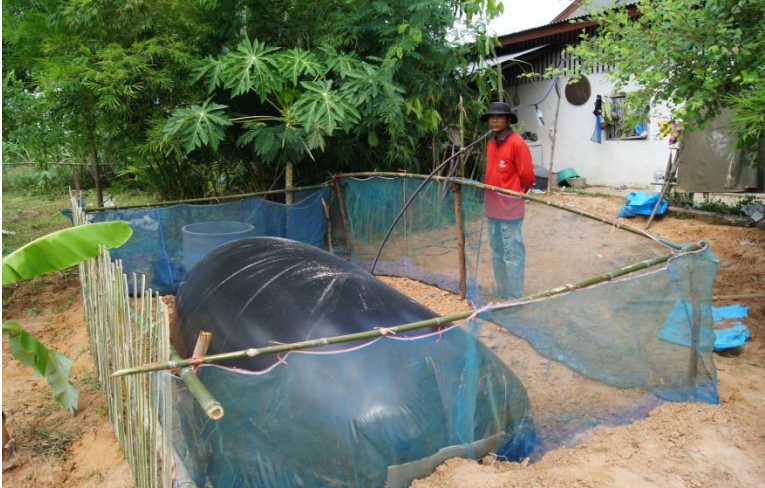
รูปที่ 18. บ่อก๊าซที่สร้างเสร็จสมบูรณ์แล้ว
