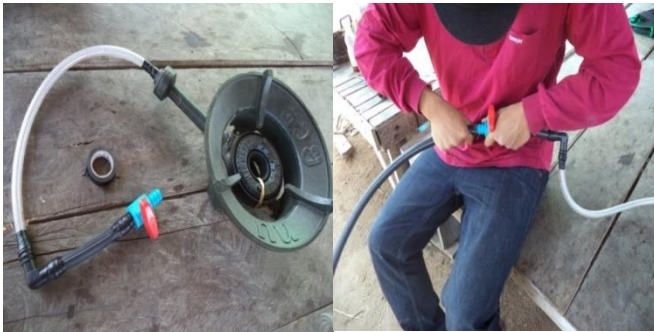
รูปที่ 17. ติดตั้งท่อส่งก๊าซและวาล์วควบคุมก๊าซ
