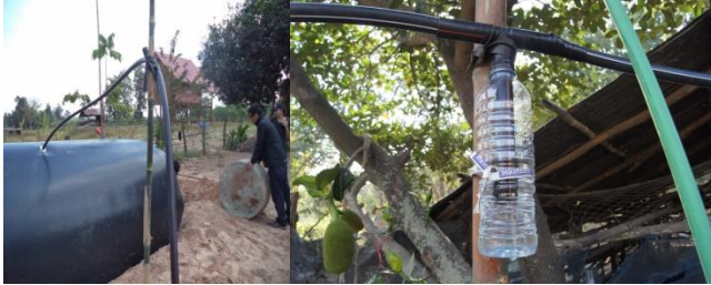
รูปที่ 16. ประกอบสายส่งก๊าซและขวดปรับแรงดัน
