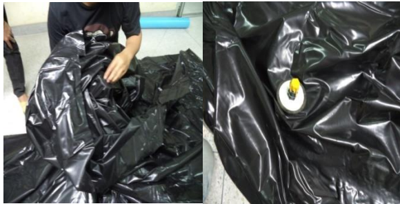
รูปที่ 11. ติดตั้งชุดส่งก๊าซ
