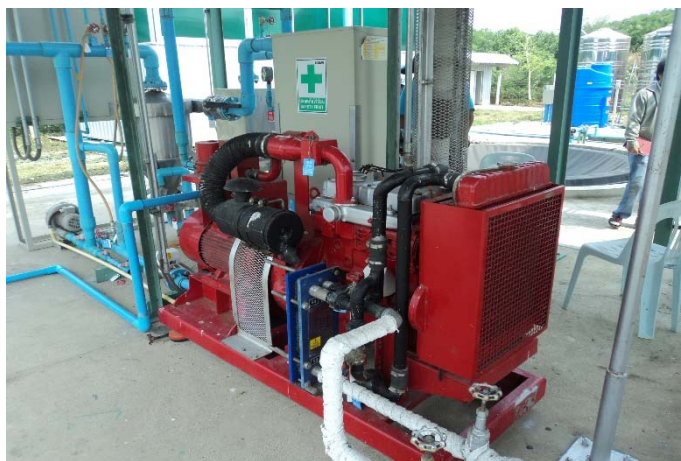
รูปที่ 5.4 เครื่องยนต์เบนซินดัดแปลงให้สามารถใช้ก๊าซชีวภาพได้ 100%
