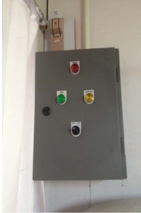
รูปที่ 6.13 ชุดควบคุมการทำงานของเครื่องดูดก๊าซชีวภาพ
