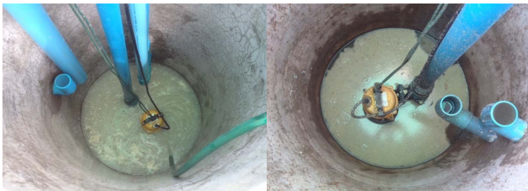
รูปที่ 8.2 การบำรุงรักษาบ่อรวบรวมน้ำเสีย
