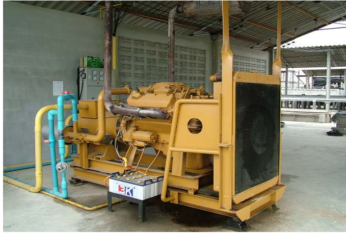
รูปที่ 5.5 เครื่องยนต์ดีเซลดัดแปลงให้สามารถใช้ก๊าซชีวภาพได้ 100%
