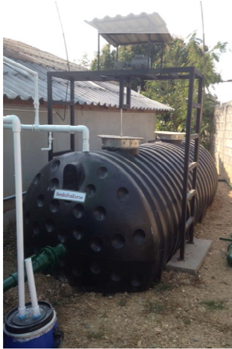
รูปที่ 6.5 ถังหมักก๊าซชีวภาพขนาด 10 ลูกบาศก์เมตร และชุดกวนอัตโนมัติ
