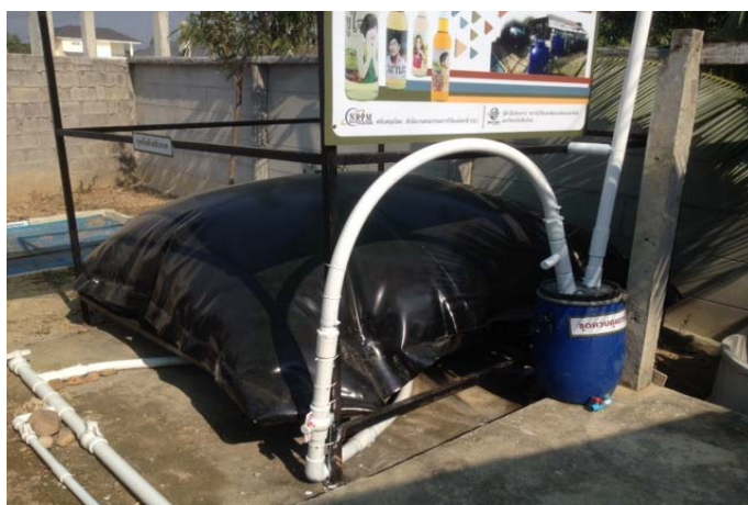
รูปที่ 6.7 ถังเก็บก๊าซชีวภาพ
