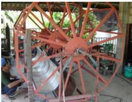
รูปที่ 4 แสดงการขึ้นโครงสร้างกังหันน้ำ
