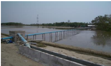
ภาพที่ 2. ท่อส่งน้ำและลำรางดินที่ใช้ในการลำเลียงน้ำทะเลจากคลองธรรมชาติเข้าสู่บ่อเก็บน้ำทะเล
