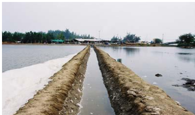
ภาพที่ 2. ท่อส่งน้ำและลำรางดินที่ใช้ในการลำเลียงน้ำทะเลจากคลองธรรมชาติเข้าสู่บ่อเก็บน้ำทะเล
