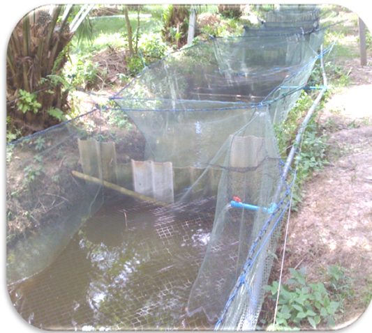
ภาพที่13 การติดตั้งระบบเติมน้ำภายในร่องสวนปาล์มน้ำมัน
