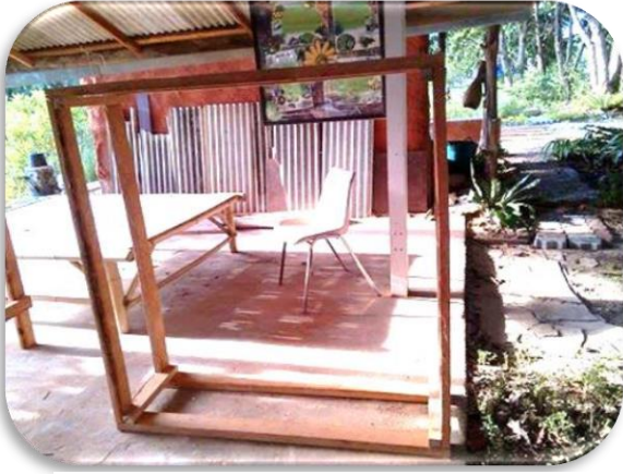
1. ทำโครงบ่อปลูกผักบุงจิ้นด้วยไม้
