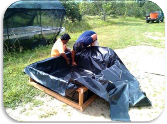
2. นำผ้ายางกันน้ำมาปูไว้กับโครงบ่อ
