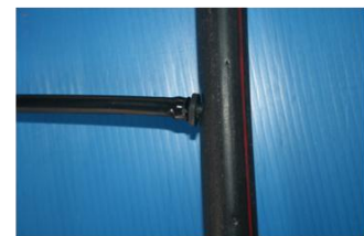
ลักษณะการต่อสายไมโครพื่อเข้ากับสายพื่อ
