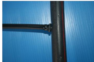
ลักษณะการต่อสายไมโครพีอีเข้ากับสายพีอี
