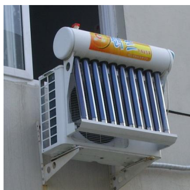
รูปที่ 3.5 เครื่องปรับอากาศ แบบ Solar Air Conditioning และวงจรการทำงาน
