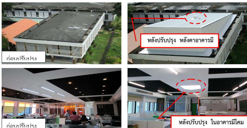
รูปที่ 1.5 แสดงภาพก่อนและหลังการปรับปรุงติดตั้งอุปกรณ์ช่องนำแสงธรรมชาติ
