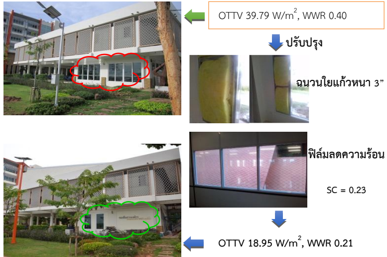
รูปที่ 1.2 แสดงผนังอาคารก่อนและหลังการปรับปรุง
