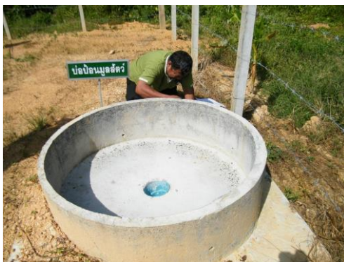
บ่อบำบัดน้ำเสีย
