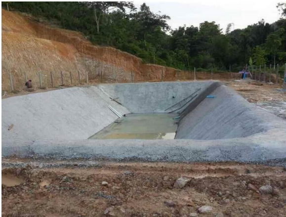
ตาดคอนกรีตบ่มก๊าซชีวภาพ
