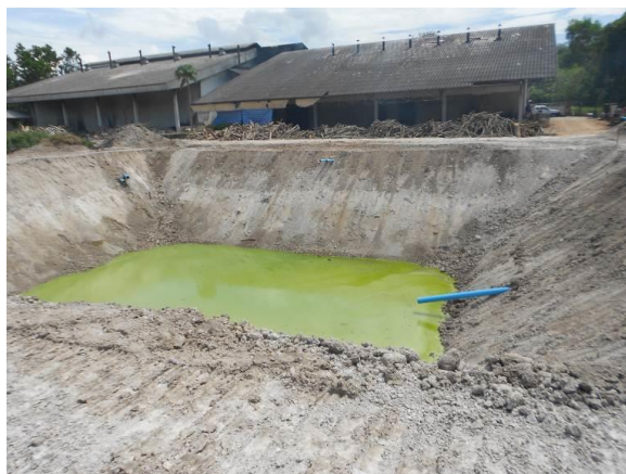
วางระบบท่อน้ำเสีย/ท่อน้ำทิ้ง/ท่อน้ำทิ้ง
