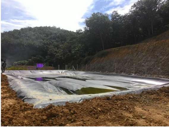
คลุมบ่อหมักก๊าซชีวภาพเสร็จ
